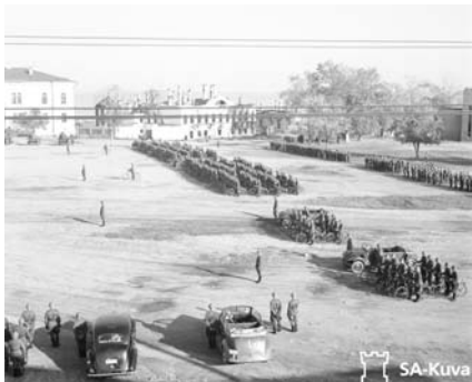
Площадь Кирова в 1942 г. На заднем плане — разрушенное здание публичной библиотеки. Фото с сайта SA-Kuva
