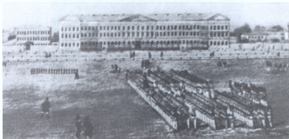
Здание военной гимназии
