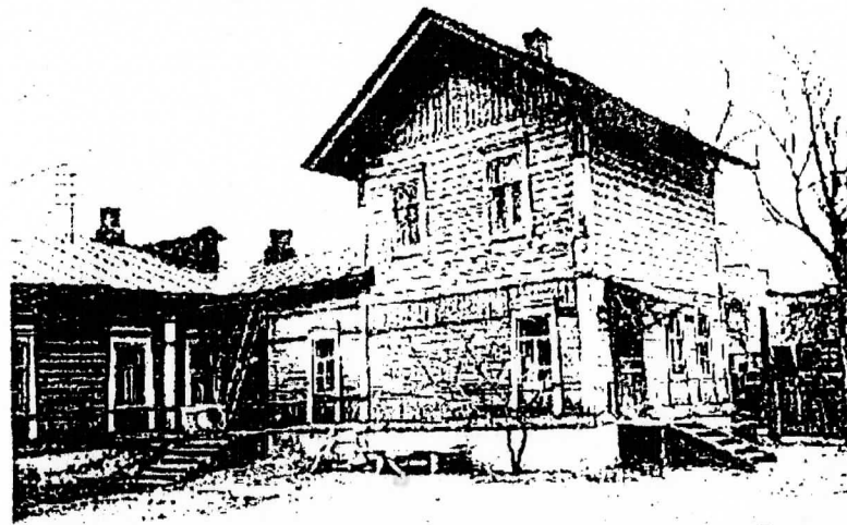
Двухэтажная пристройка к дому Плехановых. Вид со двора. (фото 1960-х гг.)
