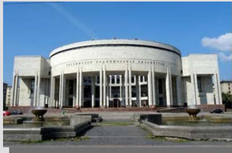
Новое здание. 1 очередь.
