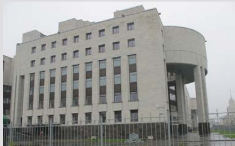
Новое здание. 2 очередь.
