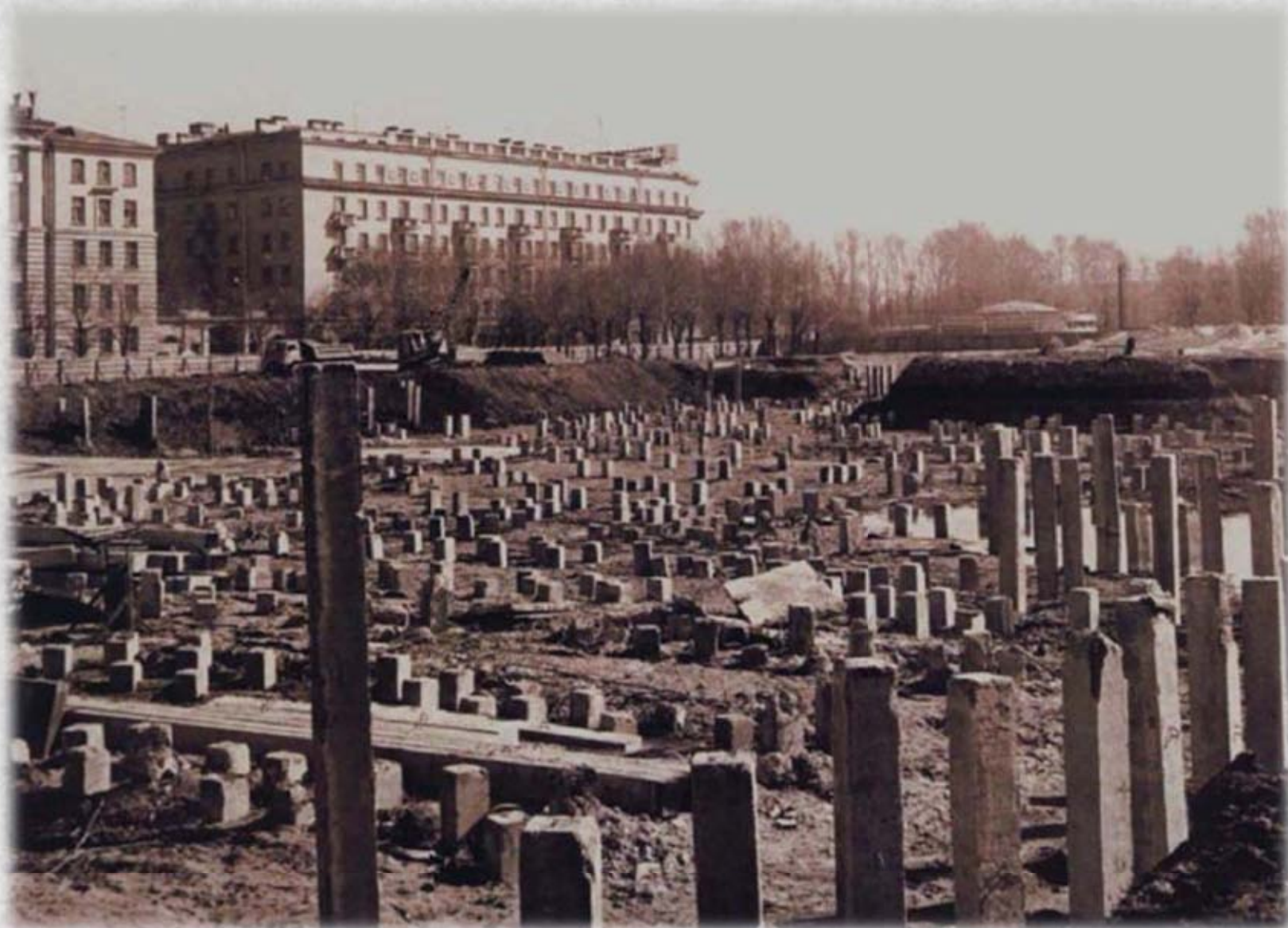
Начало строительства Нового здания Библиотеки (1986 г.)
