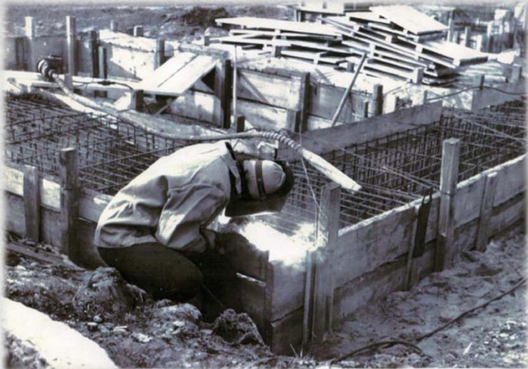
Закладка «капсулы времени» в фундамент Нового здания Библиотеки (28 октября 1986 г.)
