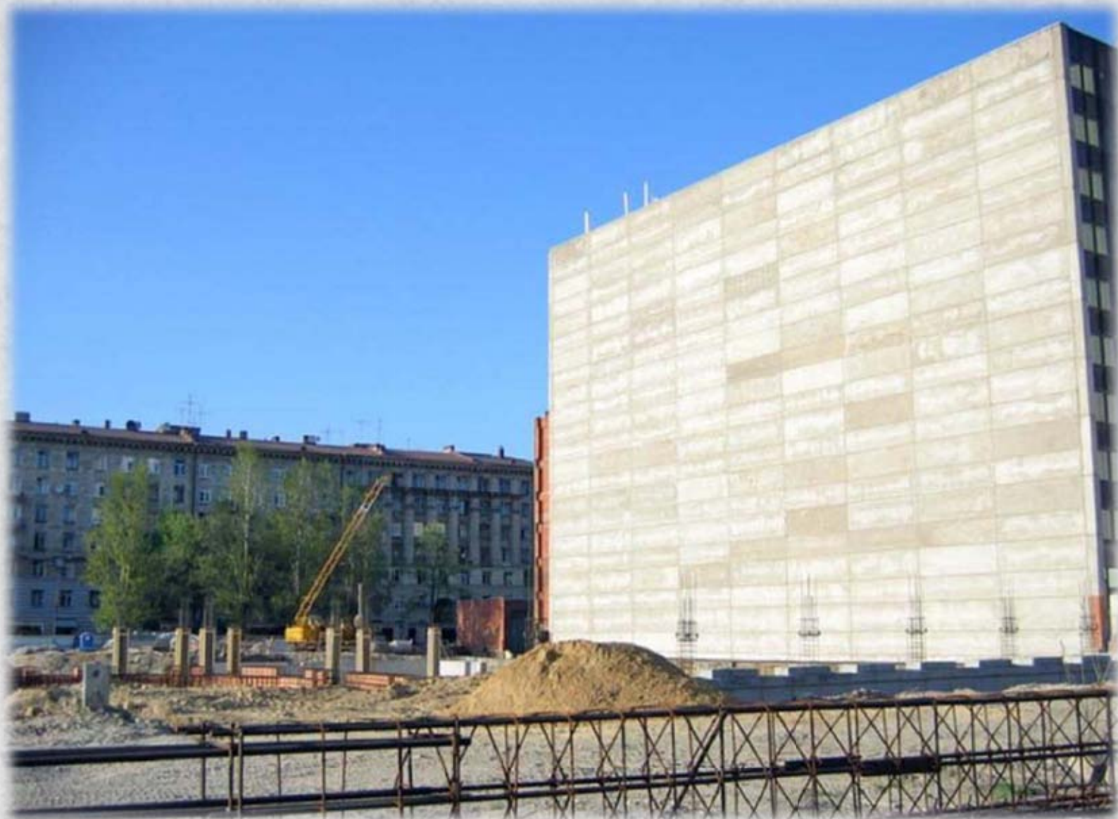
Начало строительства второй очереди Нового здания (2006 г.)
